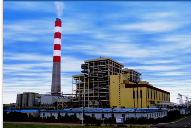
火电：自主研发的世界首台600MW超临界循环流化床锅炉在白马电厂成功投运
