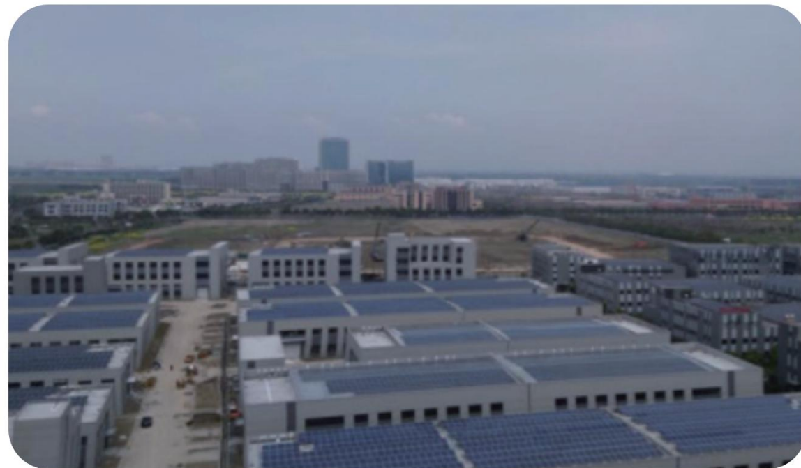
嘉兴产业园光伏电站
