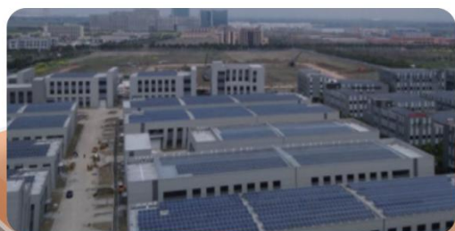
工商业 光伏系统
